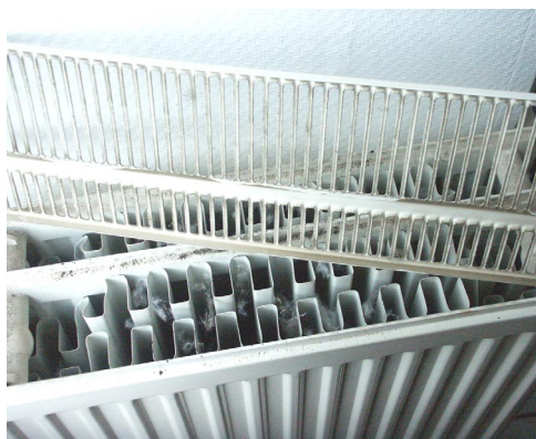
Diverse Plattenheizkörper mit Staubnestern und stark eingeschränkter Heizleistung.
