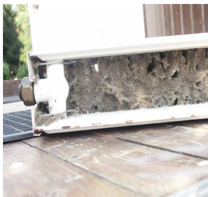
Diverse Plattenheizkörper mit Staubnestern und stark eingeschränkter Heizleistung.
